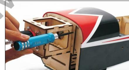
39.) Schrauben Sie die Motorplatte an das vordere Ende des Rumpfes mit M2\*6 Schrauben.
